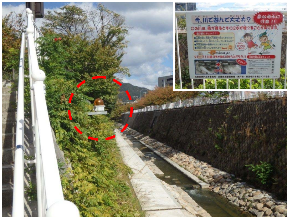
図 7.2.1 回転灯の設置 (妙法寺川)
