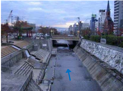
図 2.4.6 生田川上流部
