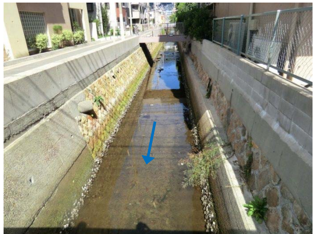
図 2.4.2 高橋川下流部
