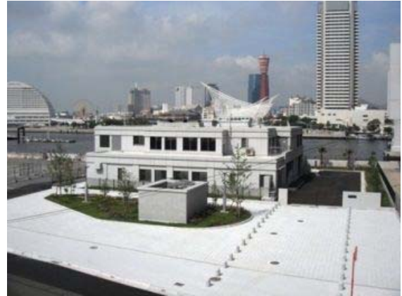
図 2.4.18 京橋ポンプ場
