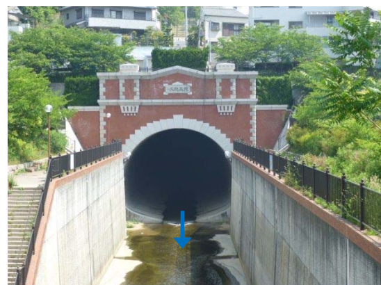
図 2.4.10 湊川隧道（新湊川） 【吐口側】
