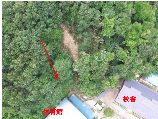
山腹崩壊の状況
