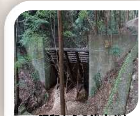
昭和からの治山ダム
