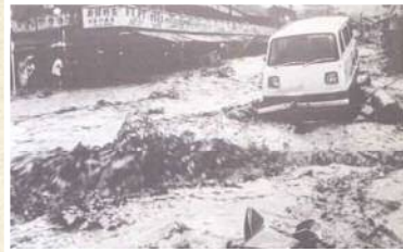
車も流され立ち往生、宇治川商店街（神戸市中央区）
