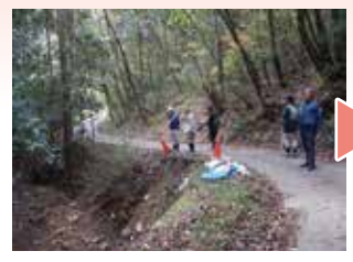
崩れそうな法面を確認
