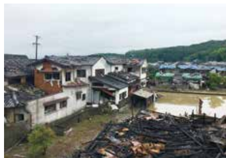
火災・爆風による周辺民家の損壊
