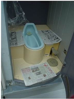
和式便器タイプの災害用トイレ*1 (車いすが入らない、手すりもない)
