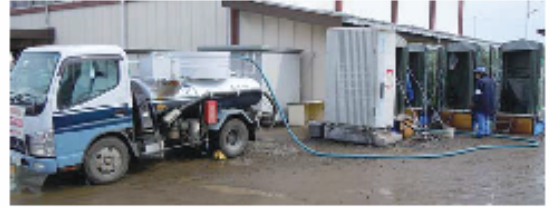
■日本大震災の被災地における災害復旧支援
