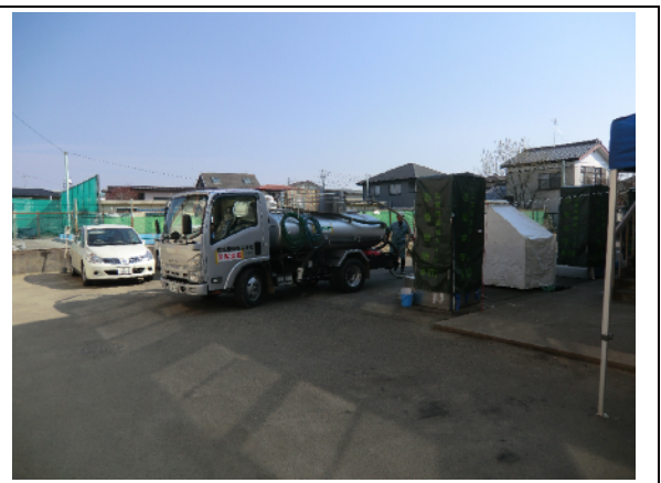
汲み取り作業中の様子(仙台市)*3
