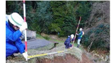
査定に向けた被災ため池の法面崩落の測量
