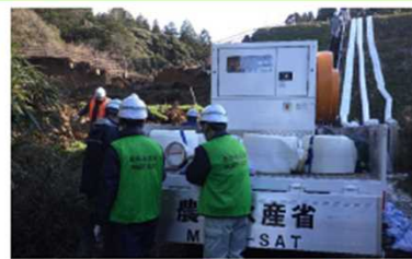
被災ため池への災害応急ポンプ車の派遣
