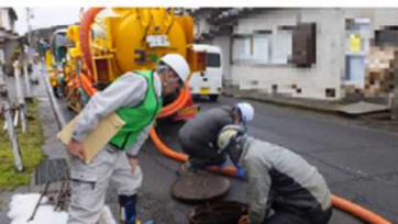
農業集落排水施設の点検
