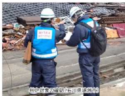
実施内容の打ち合わせ(石川県珠洲市)
