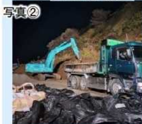
国道249号作業状況
