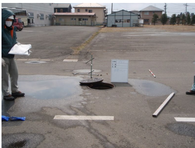
管路調査中（東松島市内）
