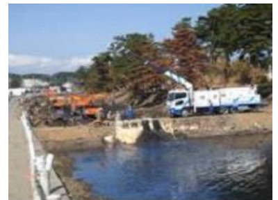
東名運河遺体捜索の排水作業
