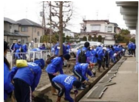
石巻市内の小学校校庭の側溝の泥だし
