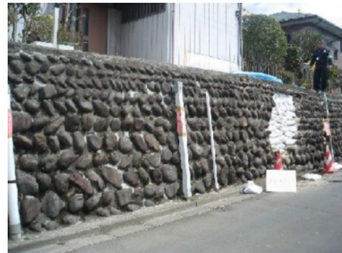
玉石空積擁壁
