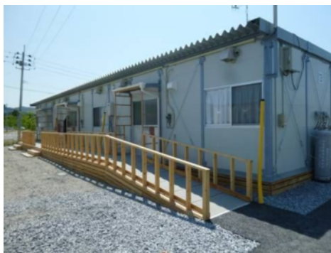
庇・風除壁・手すり
