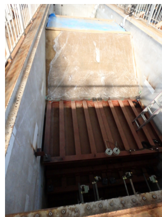
写真1 試験体盛土状況
