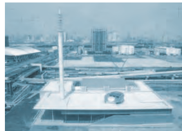
◇有明の丘基幹的広域防災拠点施設(本部棟)
