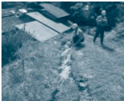
◆土砂災害危険箇所等の点検
