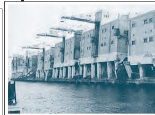
被災した上屋 (新港第8突堤)
