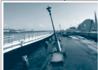
震災で被災した「メリケン波止場」の一部をそのままの状態 で保存。見学できるよう神戸港震 災メモリアルパークとして整備
