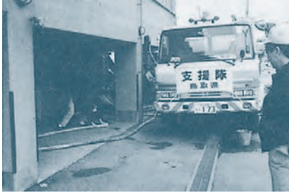
☞ 公衆浴場への給水作業
