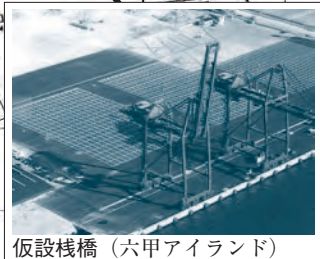
仮設棧橋 (六甲アイランド)
