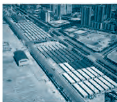
大規模仮設住宅団地を整備
