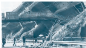
倒壊した阪神高速道路 (神戸新聞社提供)
