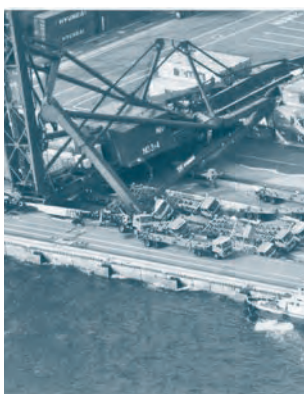
◆大きな亀裂を生じ、水没したコンテナバース(神戸市六甲アイランド)
