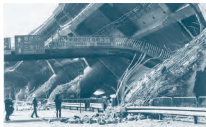
◆倒壊した阪神高速道路神戸線(神戸市)
