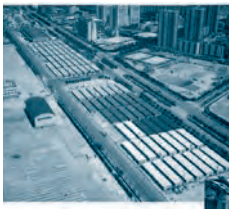
大規模仮設住宅団地を整備
