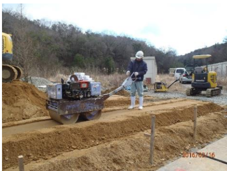
写真 9 ハンドローラーによる締固め状況
