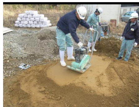
写真 10 プレートをを用いた締固め状況
