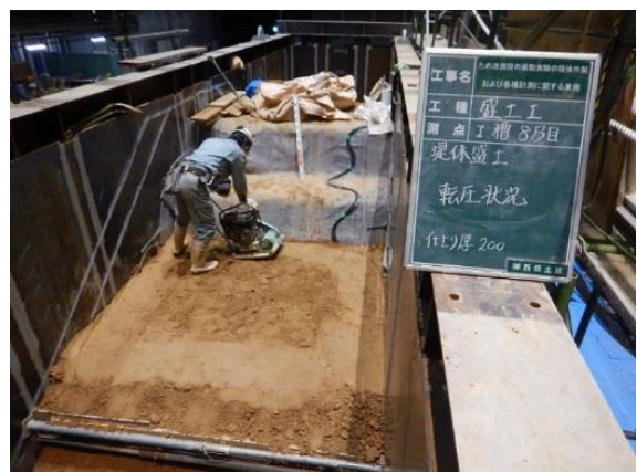
写真 17 プレートによる転圧状況
