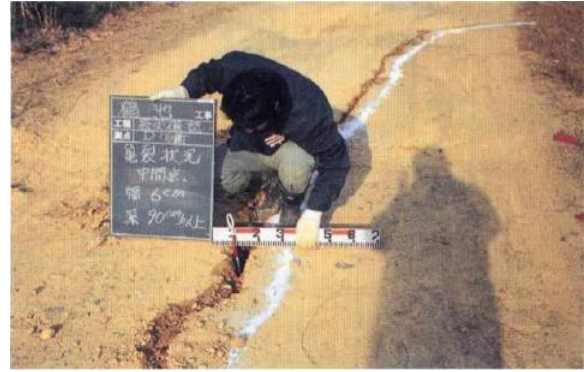
写真3 鶴池の被災状況
