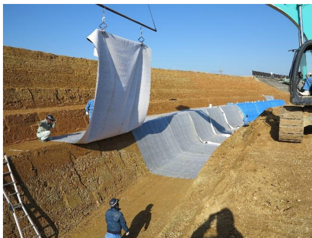
写真 4 ベントナイト系遮水シートの現場施工状況
