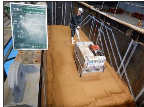
写真 13 ローラーによる転圧状況
