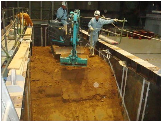
写真 14 法面整形状況
