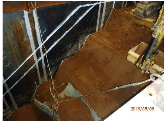
写真 15 シート敷設部の段切り状況
