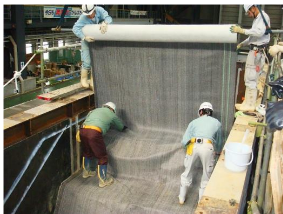
写真 16 シート敷設状況
