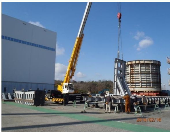
写真6 土槽組立状況
