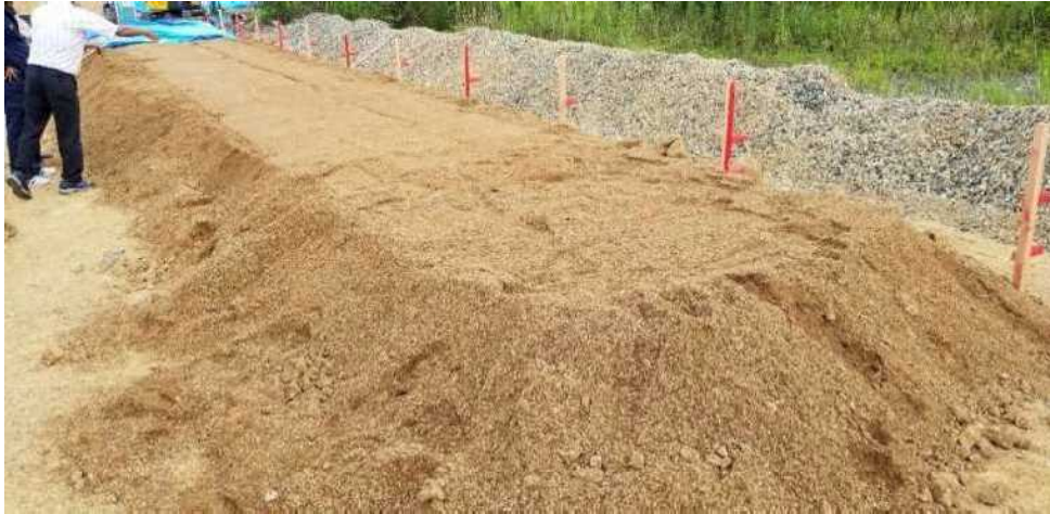
写真 3-3 試験盛土の様子
