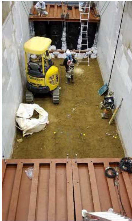
(e) 支圧板上枠を設置
