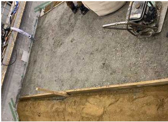
(a) 碎石層の施工(T=20cm)
