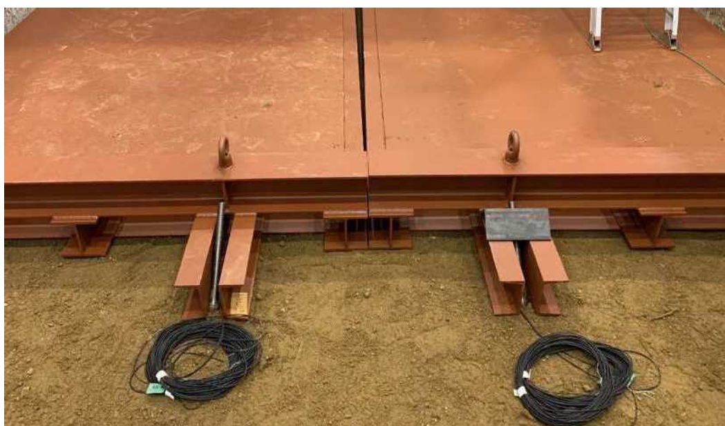
写真 3-16 下部基礎部アンカーのひずみゲージの貼り付け
