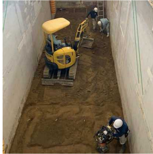
(b) 基礎地盤施工
