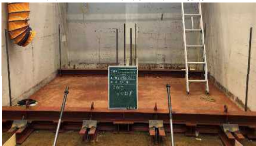
(c) 支圧板下枠を設置及びアンカーの固定
