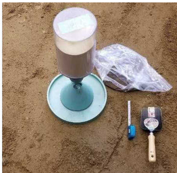
写真 3-8 砂置換法による締固め度測定
