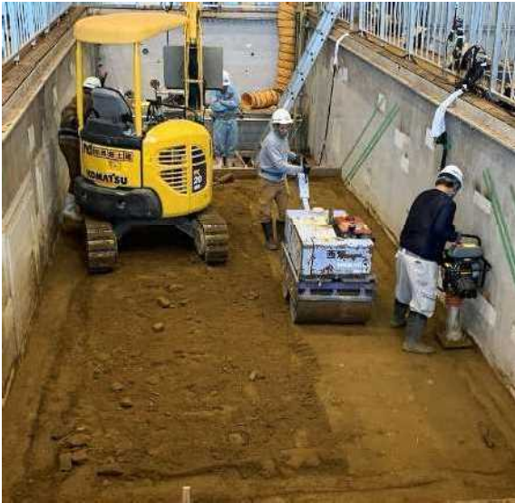
写真 3-5 ローラーによる転圧状況
