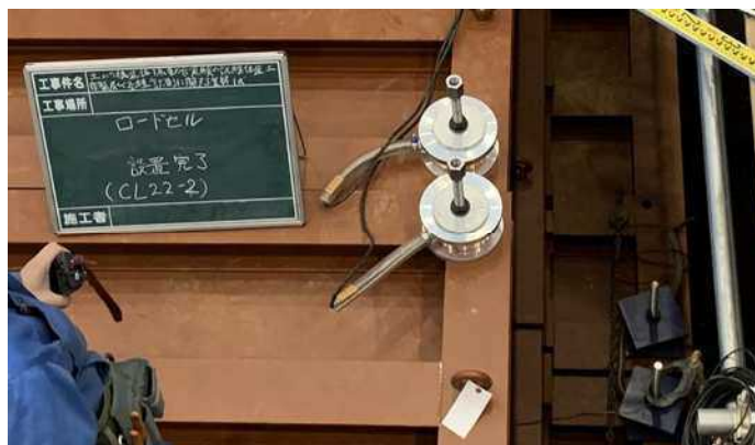
写真 3-14 荷重計の設置
