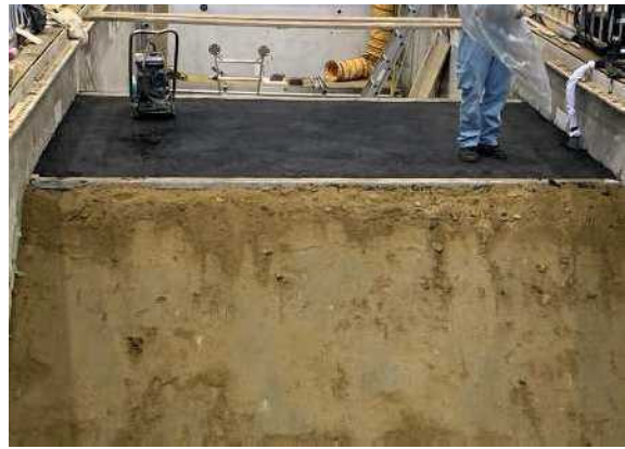
(b) 簡易舗装施工(T=5cm)
