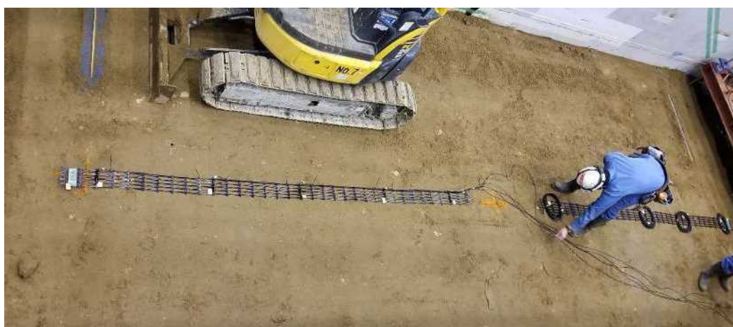
写真 3-15 すべり面推定用のひずみゲージの設置(7層目, H=1.75m)
