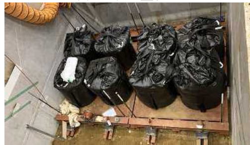
(d) 土のうの設置
