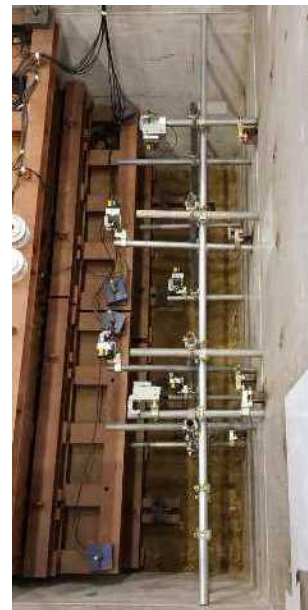
(c) 2 段タイプの変位計設置様子
