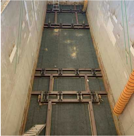
(a) アンカー取付基礎の設置
