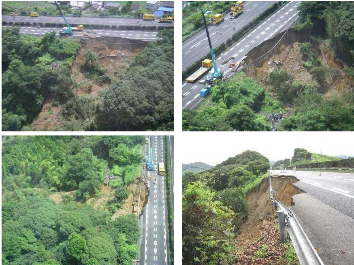
写真 1-3 損傷状況の写真
