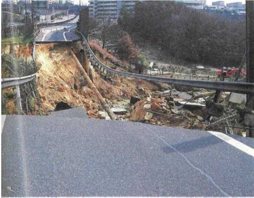
写真 1-4 大蔵谷 IC 被害状況 5)
