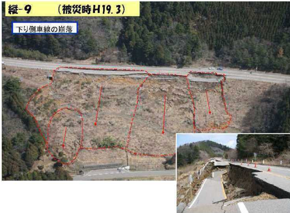
写真 1-2 能登有料道路地震被害状況写真(6.3kp, 縦-9) 2)
