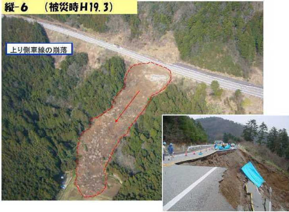
写真 1-1 能登有料道路地震被害状況写真(5.6kp, 縦-6) 2)
