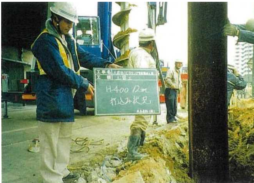
写真 1-5 大蔵谷 IC 復旧現状 6)
