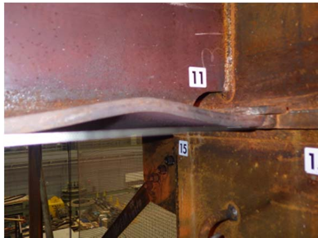
(b) 3階①側柱梁接合部
