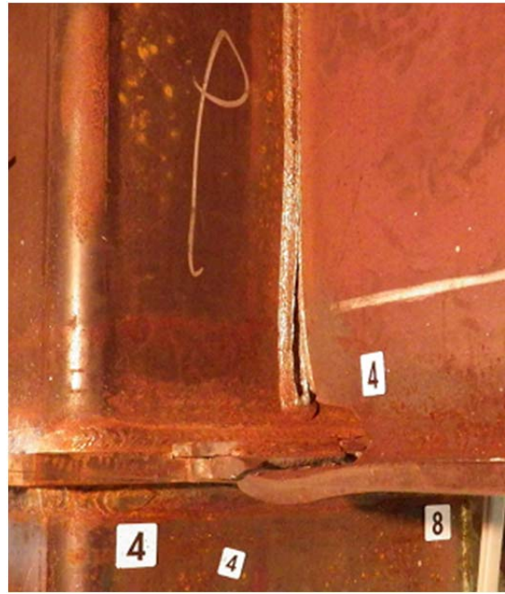
(b) 2階③側柱梁接合部
