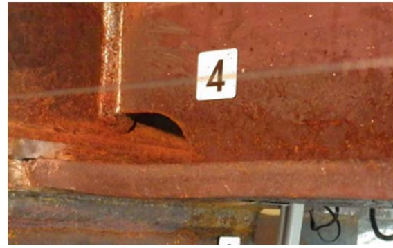
(b) 2階③側柱梁接合部
