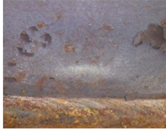
(b) 下フランジスカラップ底での母材くびれ
