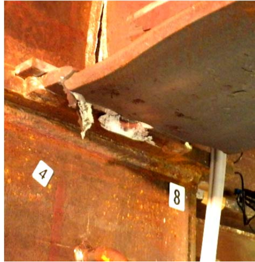
(b) 2階③側柱梁接合部
