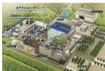
<実大免震試験施設>
