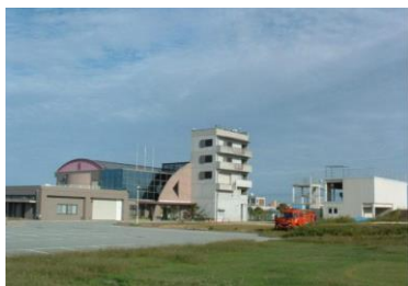
＜加古川市防災センター外観＞
