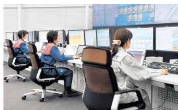
&lt;消防管制室&gt;
