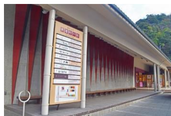
<三十三間広場の火伏壁>
