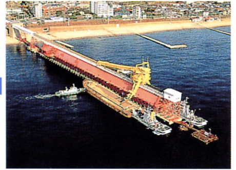
土運船への積み込み（須磨栈橋）
