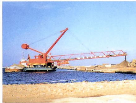
揚土（リクレーマー）
