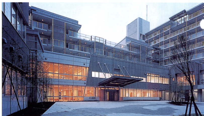
住宅の1・2階部分の特別養護老人ホーム
