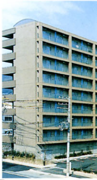
ルネシティ脇浜町・脇浜町第2 (住宅)
