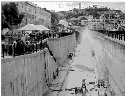
写真 13 新湊川 消火訓練状況 (御影町郡家地区)
