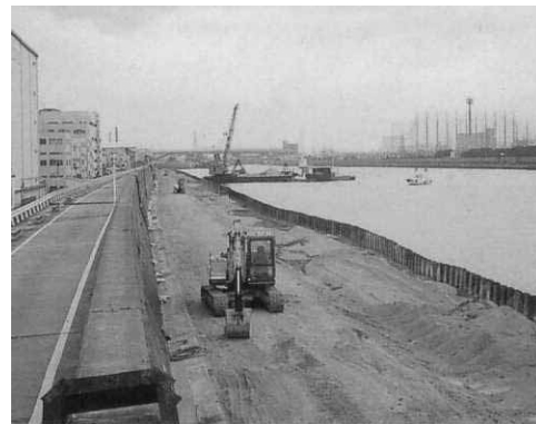
写真4 中島川 応急仮工事
