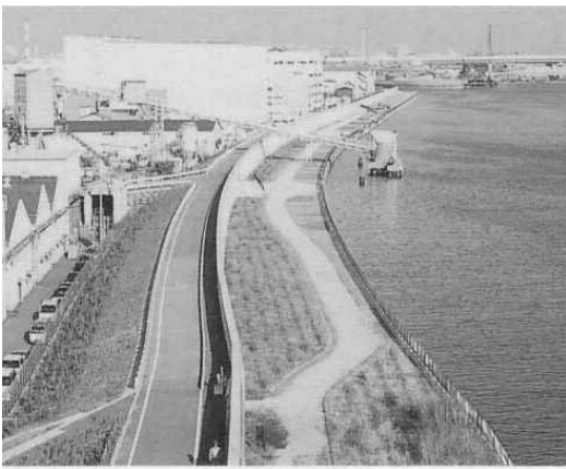
写真 11 中島川 改良復旧後
