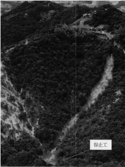
写真 9 平成 11 年 6 月に発生した崩壊
