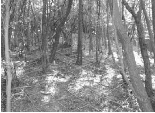
写真 1 5 ロープネット・ロックルット併用工法
