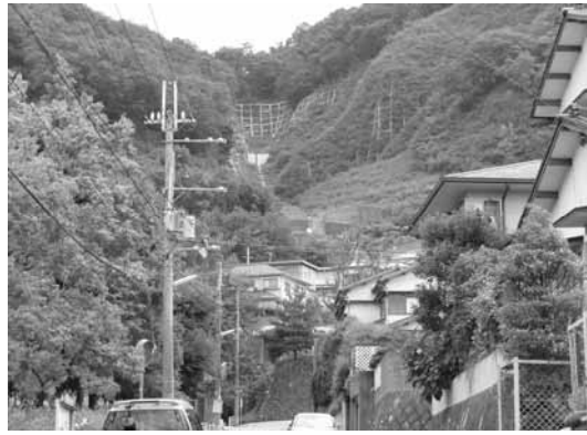
写真6 整備後 西宮市塩瀬町生瀬
