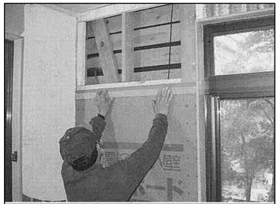
耐震ボード （内壁側から天井・床を壊さずに壁を補強する工法）
