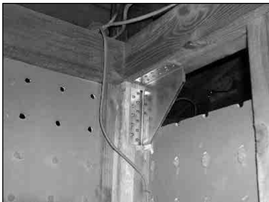
仕口ダンパー（柱と梁の接合部を補強する工法）
