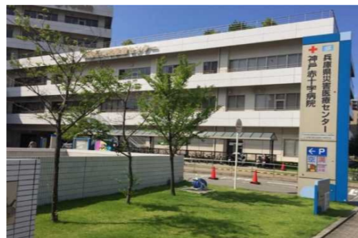
【非常用電源整備済みの兵庫県災害医療センター（重要施設）】
