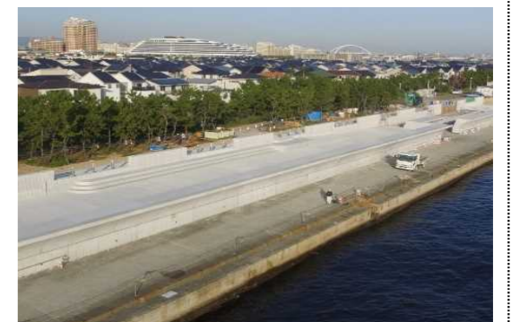
【防潮堤の嵩上げ(南芦屋浜地区)】
