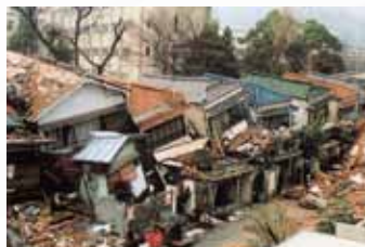
倒壊した家屋
