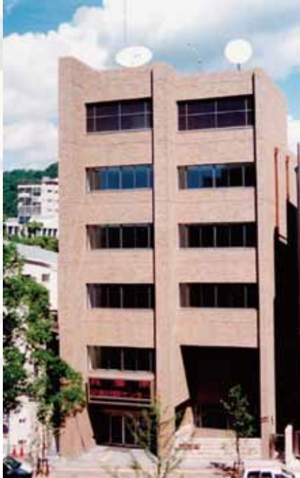
災害対策センター
