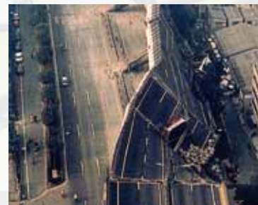
倒壊した阪神高速道路
