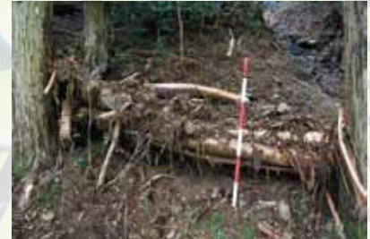
豪雨時に土留工が流出土砂を抑止
