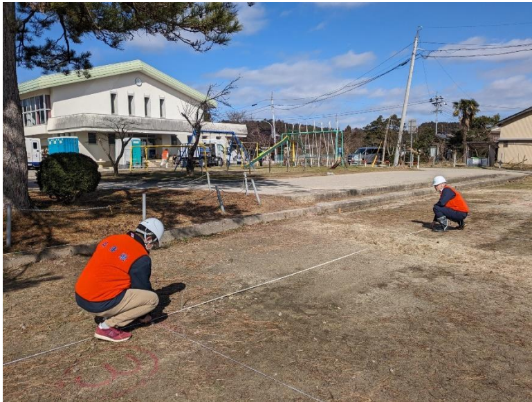
応急仮設住宅建設支援(珠洲市内)
