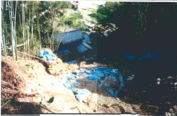
山腹崩壊（豊岡市野上）
