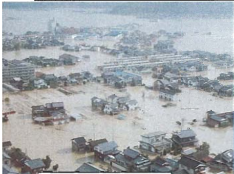
浸水状況(豊岡市)
