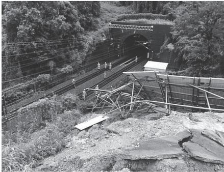
写真 113 山陽新幹線の線路脇で崩落した太陽光パネル（神戸市提供）
