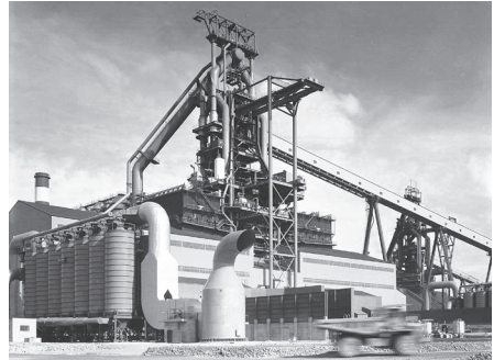
写真 45 神戸製鋼所加古川製鉄所の高炉（神戸製鋼所提供）
