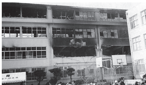
写真 244 震災直後の火災で校舎が焼失した神戸市立烏帽子中学校
