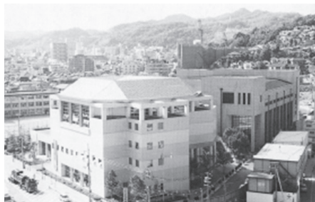
写真 210 再建した県立文化体育館
