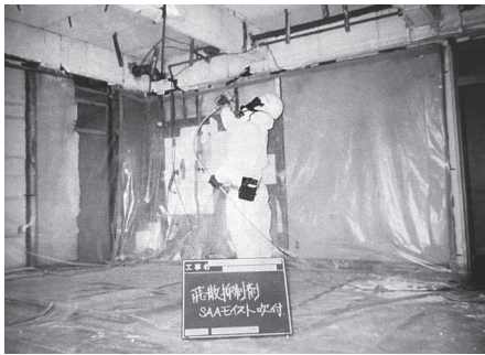
写真 187 解体現場におけるアスベスト飛散防止措置（ひょうご環境創造協会提供）
