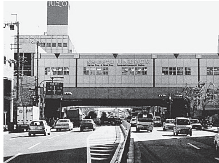
写真 121 阪急川西能勢口駅付近連続立体交差事業
