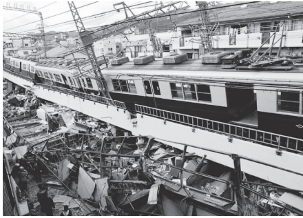
写真 118 阪神石屋川・西灘駅付近の被災状況 (神戸新聞社提供)
