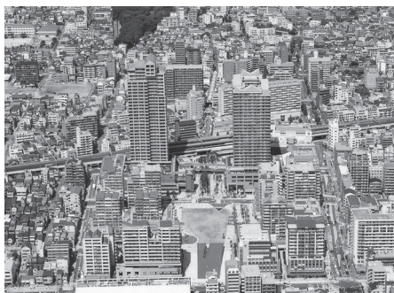
写真 95 六甲道駅南地区（平成 17 年頃）（神戸市提供）
