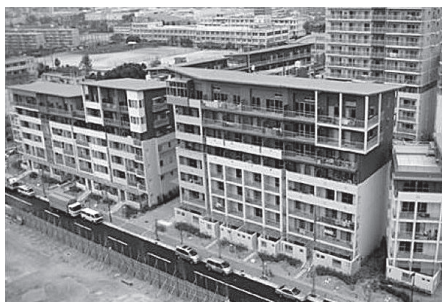
写真 99 浜甲子園さくら街（西宮市） （都市再生機構提供）
