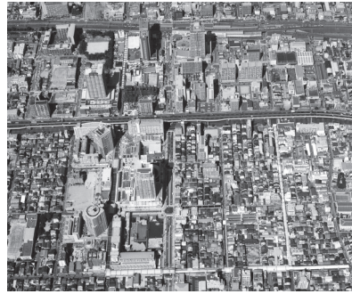
写真 94 新長田駅南地区 (平成 17 年頃) (神戸市提供)
