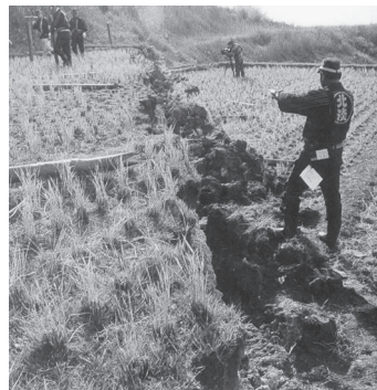
写真 69 野島断層による田面の亀裂
