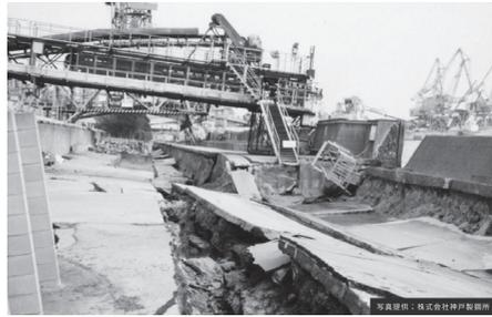
写真 59 震災により被害を受けた神戸製鋼所の岸壁（神戸製鋼所提供）
