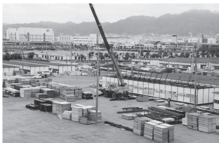
写真6 急ピッチで建設が進む応急仮設住宅(人と防災未来センター提供)
