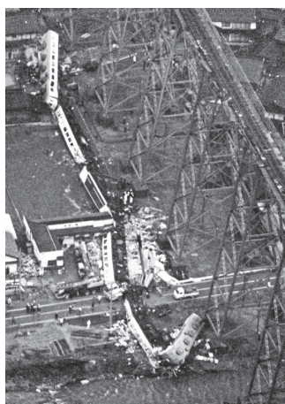
写真 91 余部鉄橋列車転落事故 (朝日新聞社提供)
