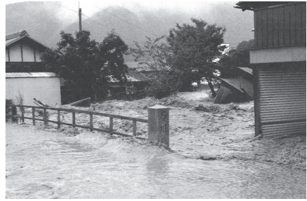
写真 87 昭和 58 年台風第 10 号による 河川氾濫（山南町）
