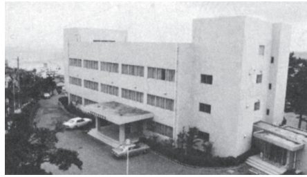
写真 19 兵庫県自治研修所
