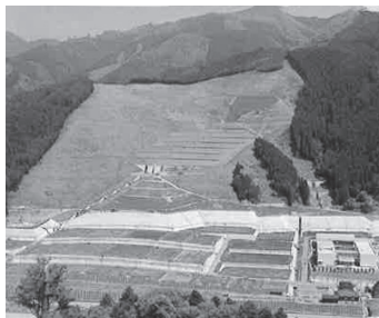
写真 76 昭和 51 年災害の山地崩壊（左）と治山工事（右） （宍粟郡一宮町）
