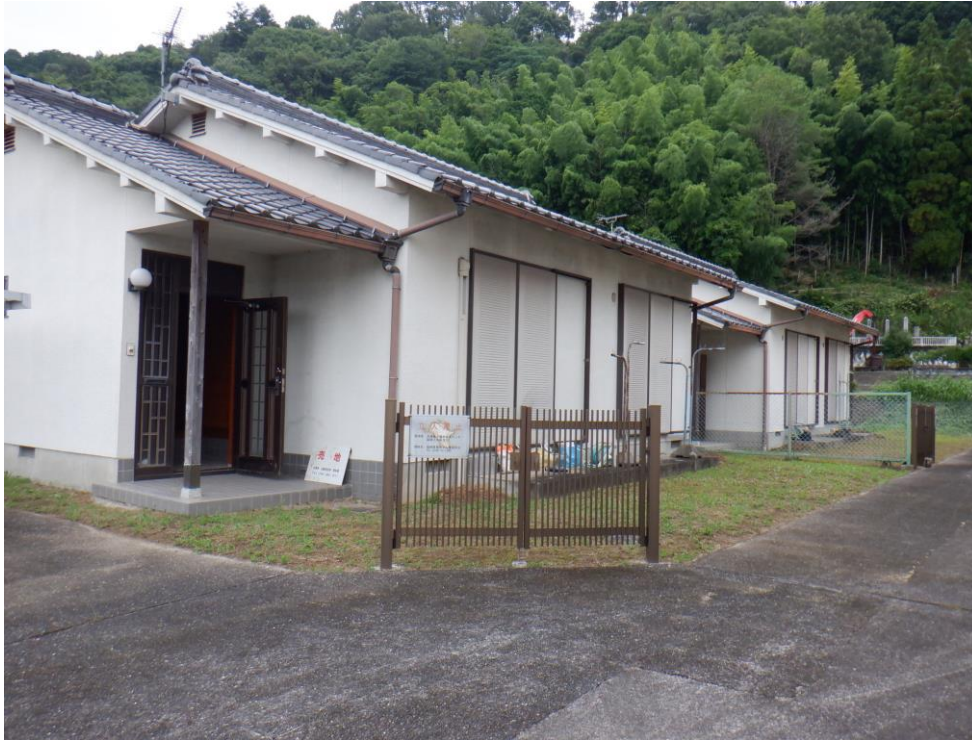
① 南西方より(手前建物が140-15、奥が140-16)
