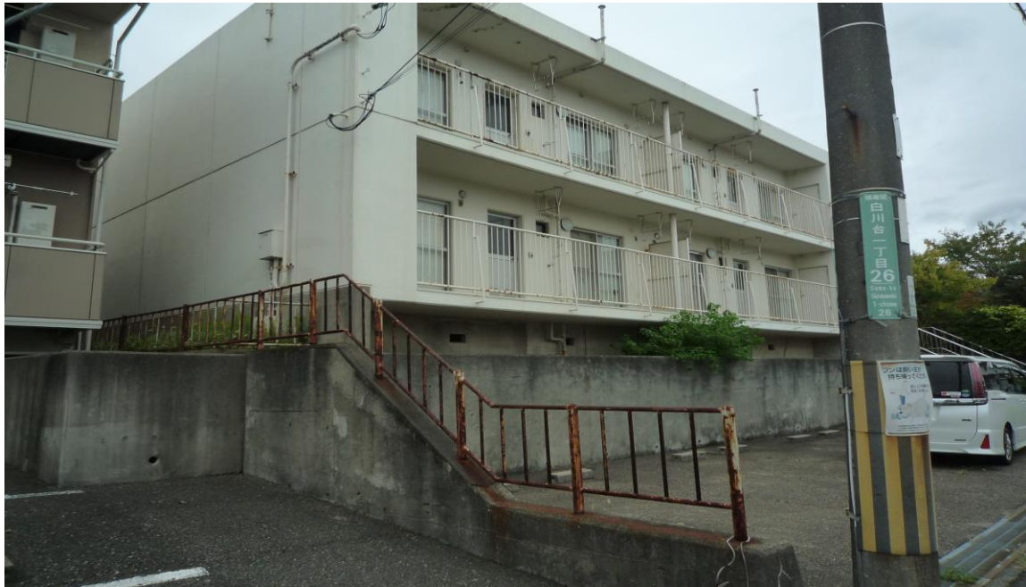
③全体図(南西方より)
