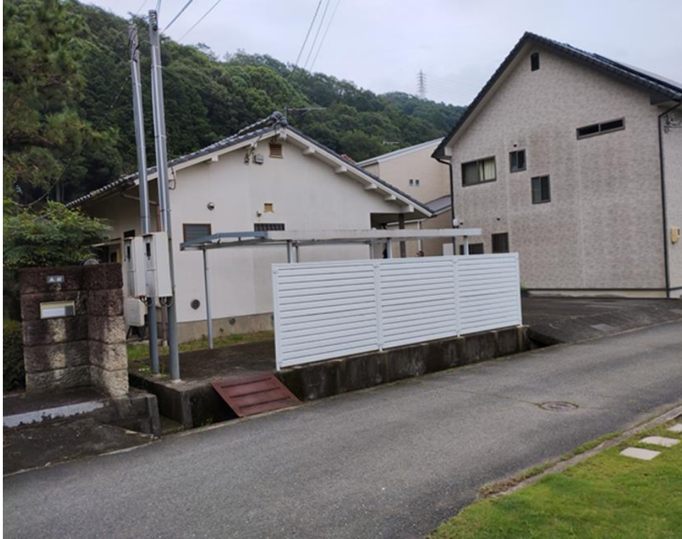
③北西方より
