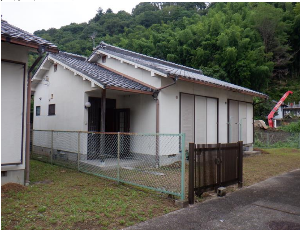
② 南西方より(140-16)
