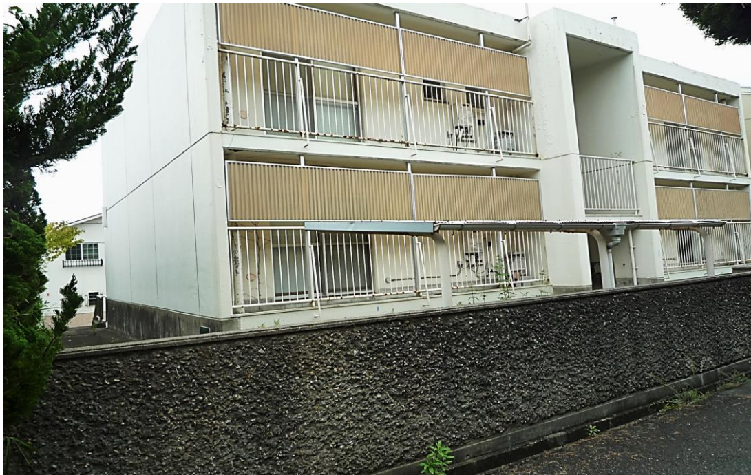
② 全体図(北東側より)
