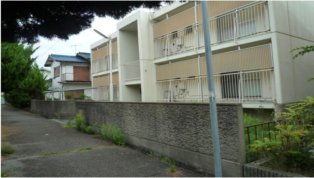
① 全体図(北西方より)
