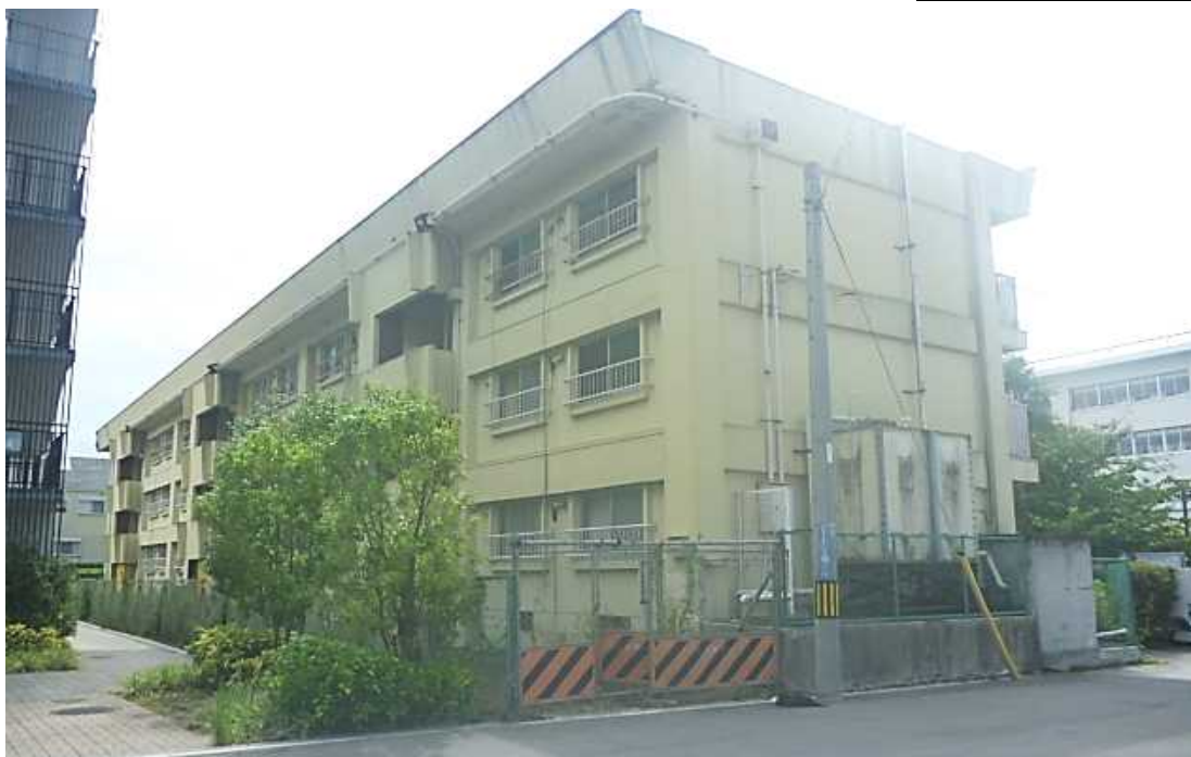
建物(北西面) ※道路(市道第890号線)から撮影
