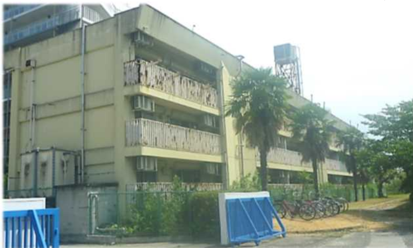
建物(南西面) ※敷地南側(武庫荘総合高校内)から撮影
