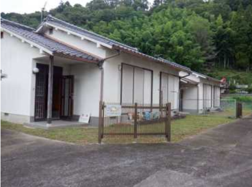
① 南西方より(手前建物が140-15、奥が140-16)
