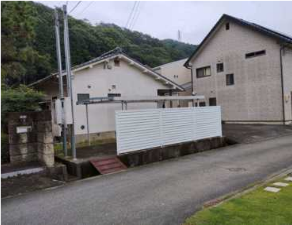
③北西方より
