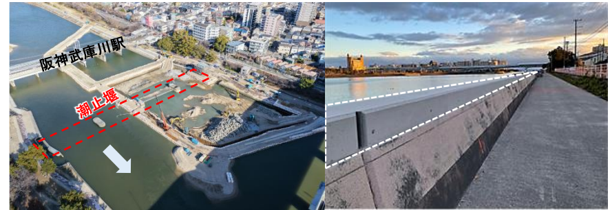
武庫川 河川改修(潮止堰撤去)
