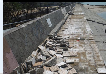
③ 護岸破損(チャンネルパーク)
