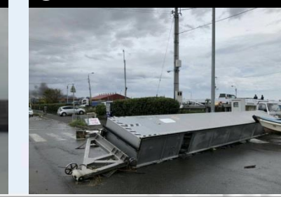
⑧ 陸閘損壊 3基
