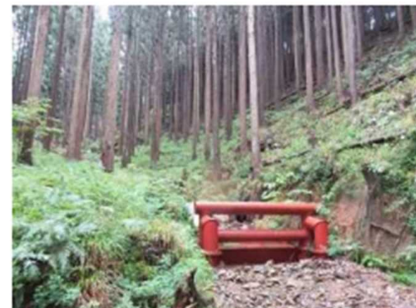
緊急防災林整備（渓流対策）（宍粟市）
