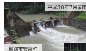
□ 治山ダムによる流木捕捉事例
