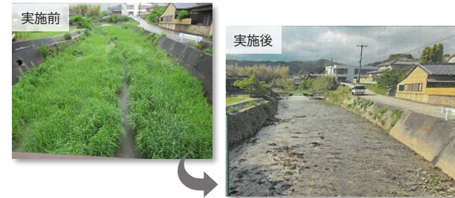
□ 河川の堆積土砂撤去
