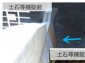
□ 治山ダムによる土石等捕捉事例
