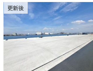
□ 港湾施設の更新 係留施設 (姫路港)[姫路市]
