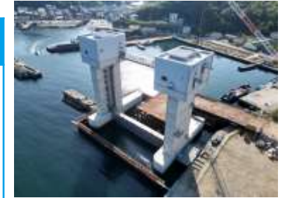
沼島漁港 水門整備
