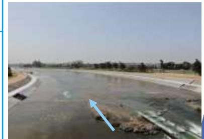
武庫川 河川改修
