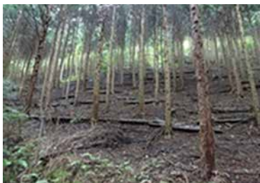
土留工の設置により、下層植生が回復し表面侵食防止機能が向上
