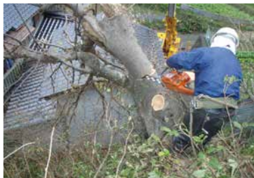
クレーンを用いた人家裏の危険木伐採
