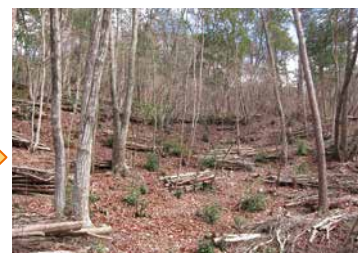
本数調整伐後に、土留工を設置
