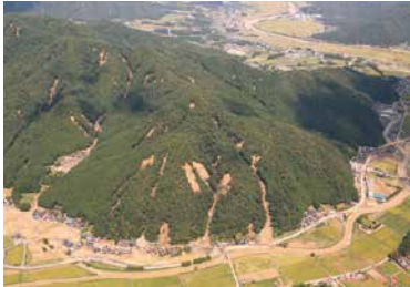
谷上流部の斜面崩壊 (平成26年8月豪雨)
