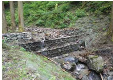
簡易防災施設が土砂を捕捉
