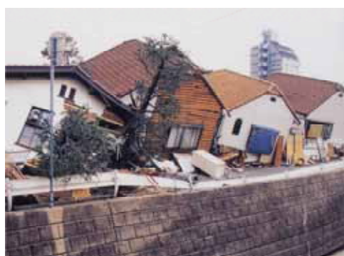
倒壊家屋を支えた庭木(神戸市東灘区)
